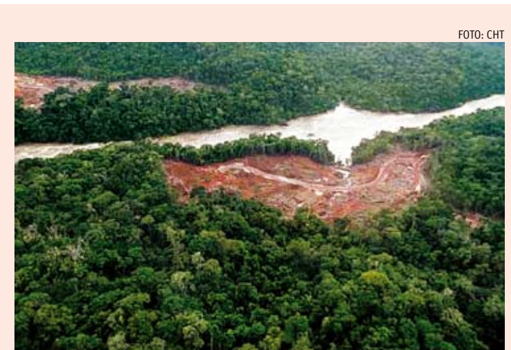
FOTO: CHT Parte de la selva removida para instalar la central de Teles Pires.
