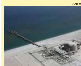
Terminal de Gas Natural Licuado Mejillones.
